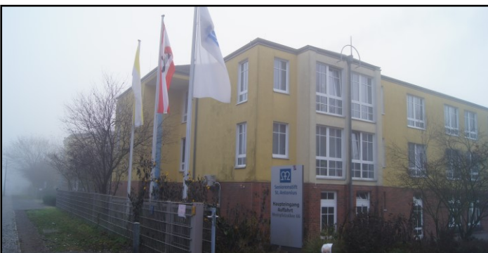
Im Erdgeschoss dieses zum Seniorenstift St. Antonius gehörenden Gebäudes wurde Anfang Februar die zweite KV-Praxis in Lichtenberg eröffnet. Fotos dieser Seite: Herbert Schadewald
