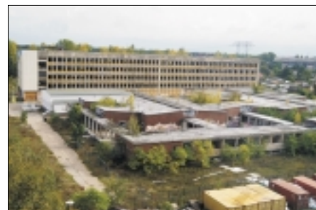
Eines der ehemaligen Redaktionsgebäude des DDR-Rundfunks mit dem einstigen Sendestudiokomplex im Vordergrund.
